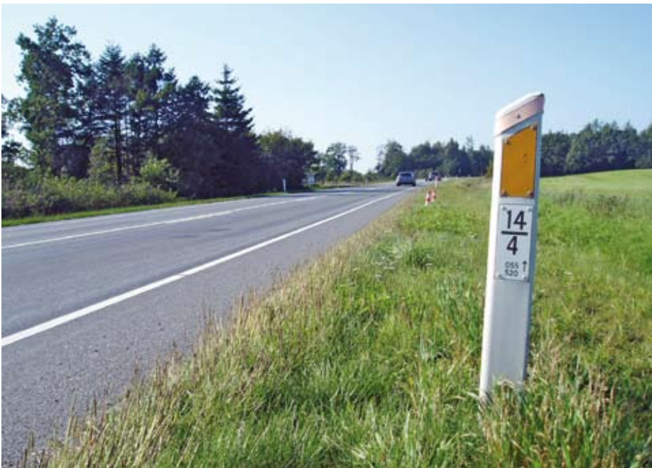
Figur 4. Forsøgsstrækningen med 6 forskellige typer overfladebehandling på hovedlandevej 520.
