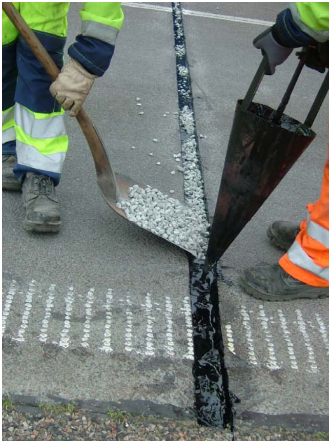
Figur 1. På E20 ved Holsted er flere dårlige fuger i betonbelægningen repareret ved brug af teknikken for stenfyldte fuger.
