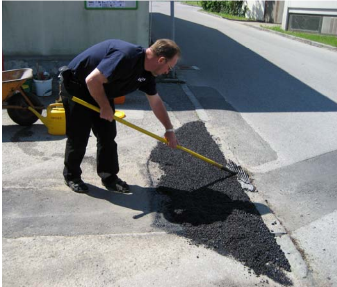
Figur 2. Reparation af slaghuller og andre mindre skader kan med fordel foretages med kold lappeasfalt. Det viste produkt (Rephalt) leveres i spande og aktiveres ved tilsætning af vand.
