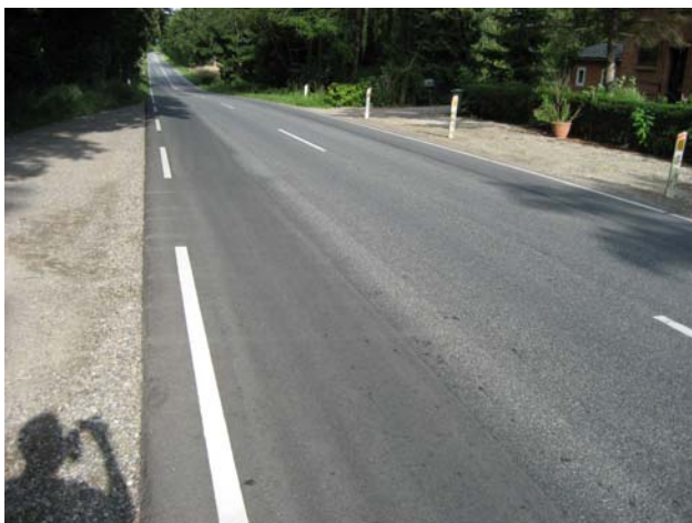
Figur 3. Skulderopretning på ldv. 704 foretaget med en speciel SMA-lignende asfalt med relativ blød bitumen tilsat polymer. Bemærk at samlingen til den eksisterende belægning er lagt i kanten af højre hjulspor, så sporet også er fyldt op.
